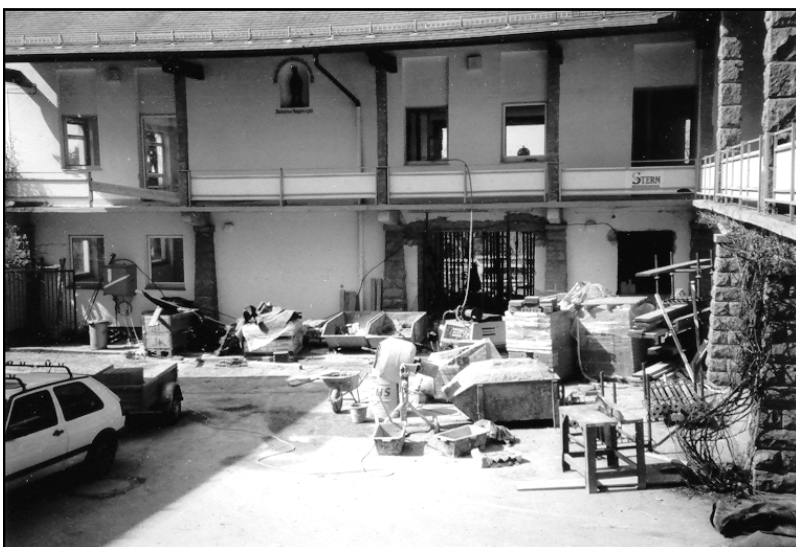
März 2004, Beginn der Kindergartensanierung
