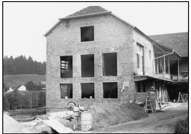
Kindergartengebäude im Rohbau
